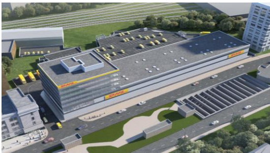
Адм. складской комплекс DHL
